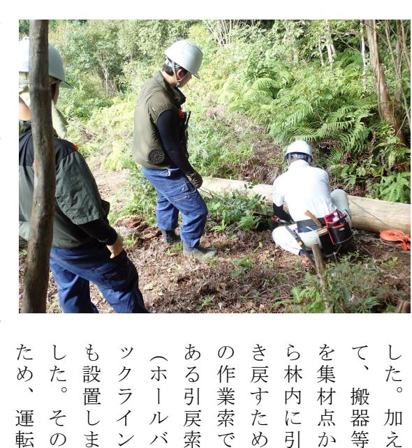
した。加えて、搬器等を集材点から林内に引き戻すための作業索である引戻索（ホールバックライン）も設置しました。そのため、運転した。
