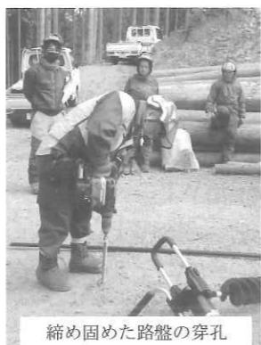
締め固めた路盤の穿孔
